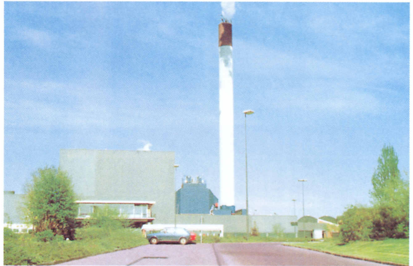
Die größte Schlammmentwässerungsanlage Europas: Emscherfluß-Klärwerk Bottrop.
