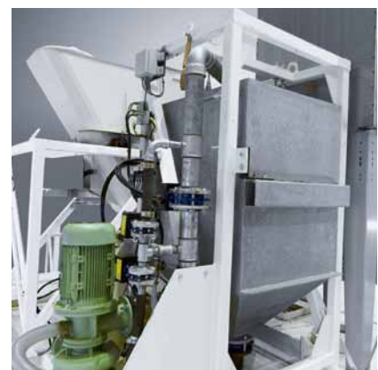
Die Wasserwaage mit Entleerpumpe für die Zugabewasser-Druckeinspeisung in den Mischer.
