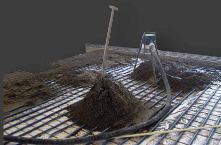
Sand, Zement, Wasser und Zusatzmitteln werden vollautomatisch vermischt und zur Baustelle transportiert.
