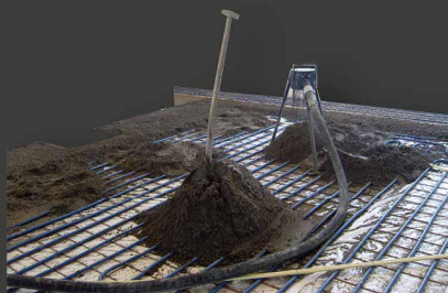
Sand, Zement, Wasser und Zusatzmitteln werden vollautomatisch vermischt und zur Baustelle transportiert.
