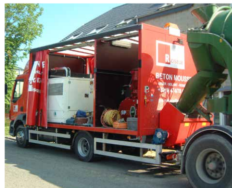
Fahrmischer liefern Mörtel an, der von der Maschine aufgeschäumt und verpumpt wird.
