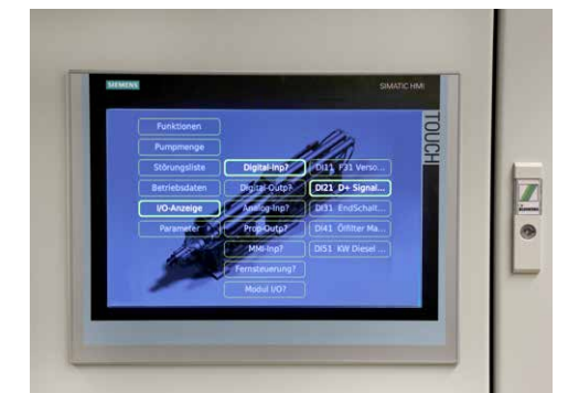
Touchpanel der SPS-Steuerung für die Bedienung des Dickstoffpumpensystems
