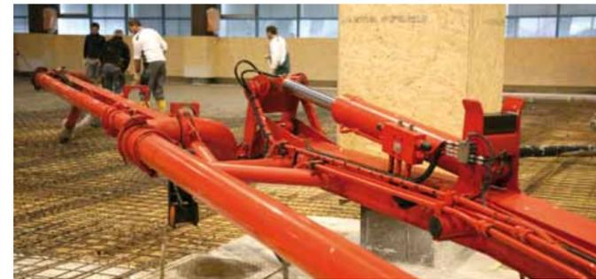
In Arbeitsstellung befinden sich die Hydraulikzylinder des Auslegers oberhalb des Mastprofils. So sind sie vor Betonspritzern und evtl. Beschädigungen gut geschützt.
