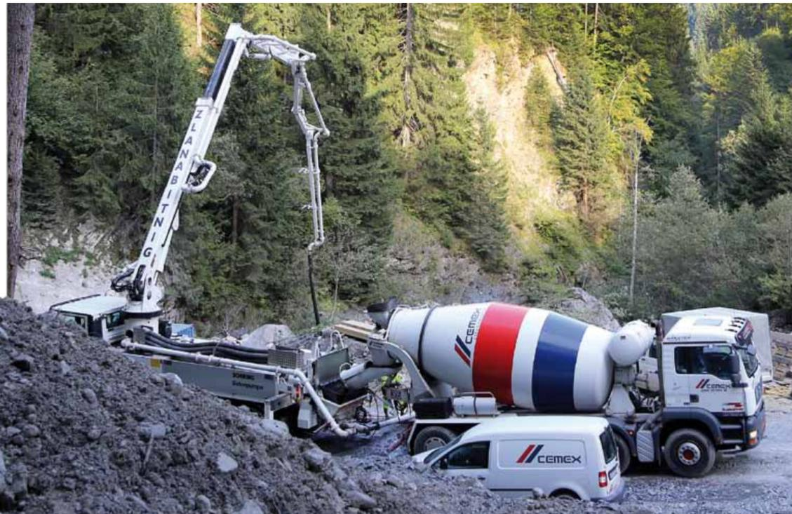
Wenn der Ausleger einmal in die Grundstellung gebracht worden ist, braucht sich der Anwender nur auf die Funktion des Teleskopierens zu beschränken. Auf diese Weise kann er einen 4,60 m breiten Streifen betonieren, ohne den Verteilermast dabei falten zu müssen. Der Endschlauch hält automatisch seinen Abstand zur Bodenplatte, das Hydrauliksystem wird geschont, denn die Steuerbewegungen reduzieren sich auf ein Minimum. Dies bedeutet ein stressfreieres und sichereres Arbeiten für den Maschinisten.
