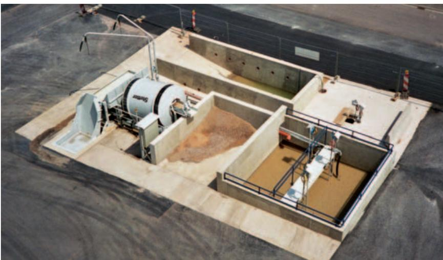
*Übersicht einer RA 12: Zusätzlich zum Rührwerksbecken sind optional Absetz- und Oberflächen-Wasserbecken installiert.*
