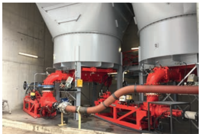
Förderung von entwässertem Klärschlamm in einem Zementwerk Deutschland
