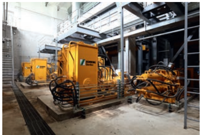
Förderung von entwässertem Klärschlamm in einer Kläranlage China
