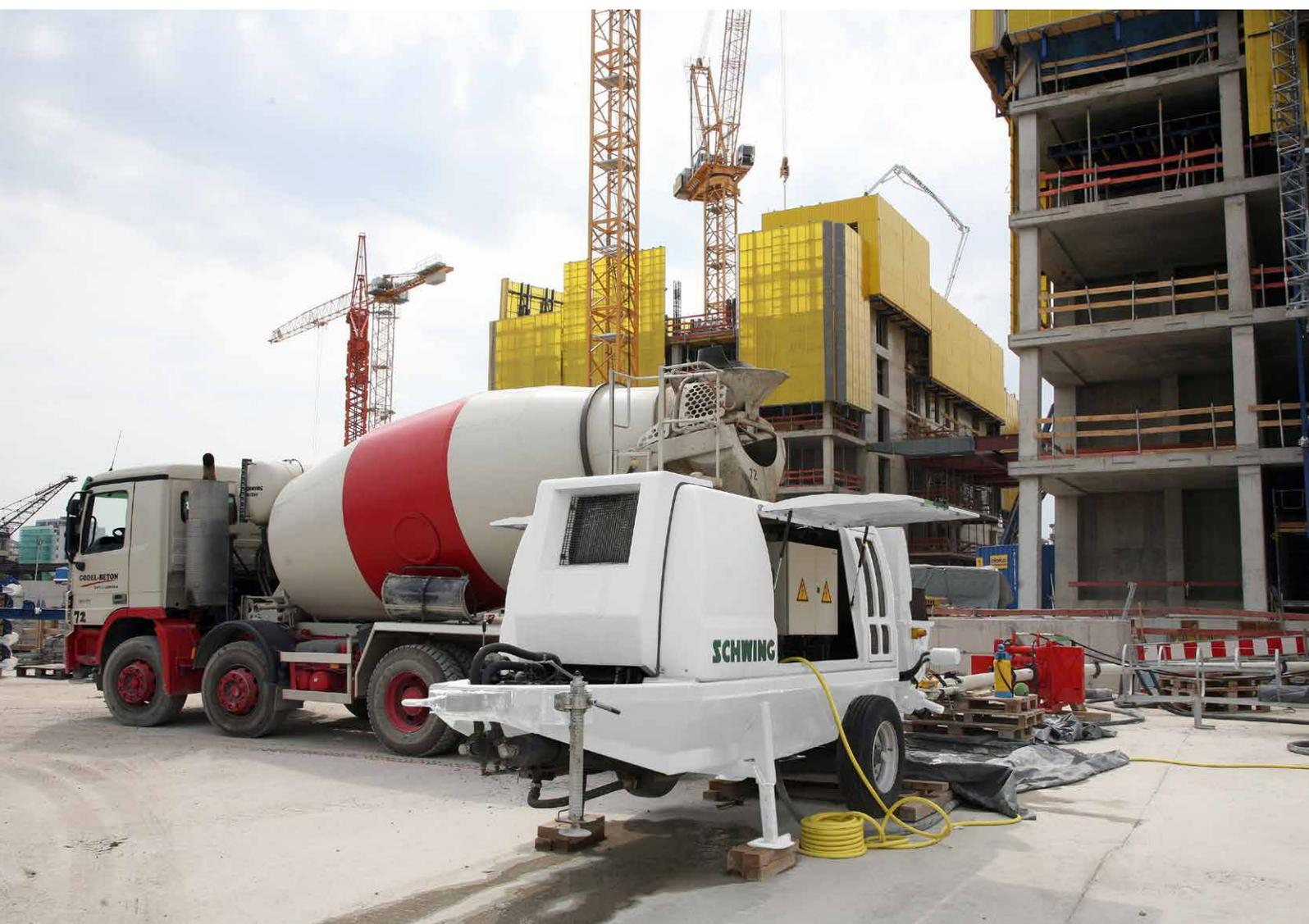
Stationäre Betonpumpen von SCHWING.
